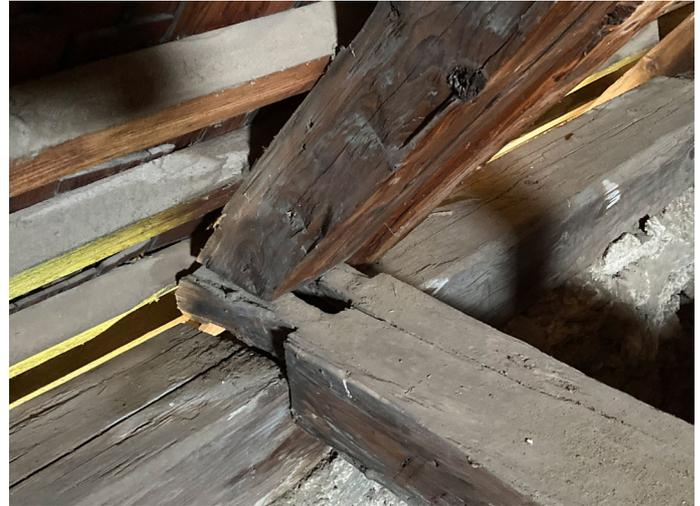
Abb. 21: Osttrakt, Bundtram mit Zapfenloch aber Sparren ohne Zapfen (Foto: M. Aigner 2023).
