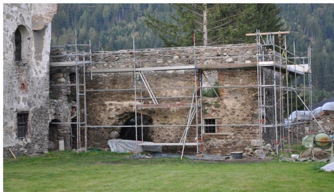
Abb. 66: 26. September 2016: Rekonstruktionsarbeiten an der Mauerkrone des Nebengebäudes.
