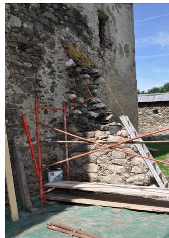
Abb. 68: 15. August 2019: Rekonstruktionsarbeiten am Stützfeiler an der Ostseite.
