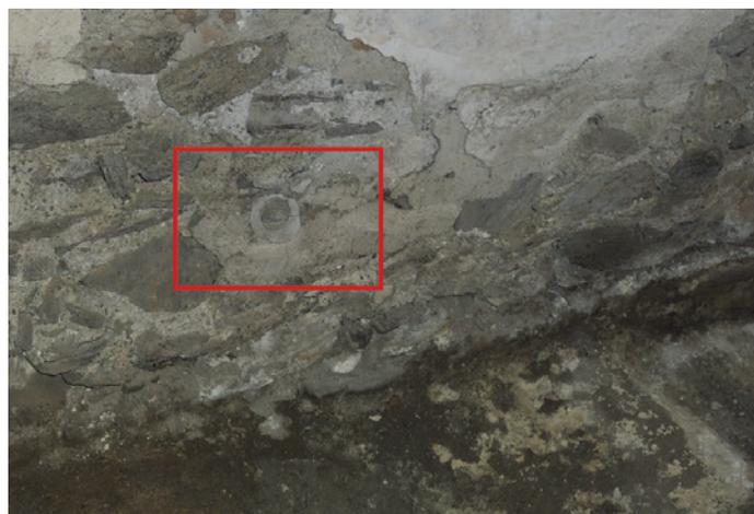
Abb. 65: Hölzernes, vermauertes Ausgusrohr
