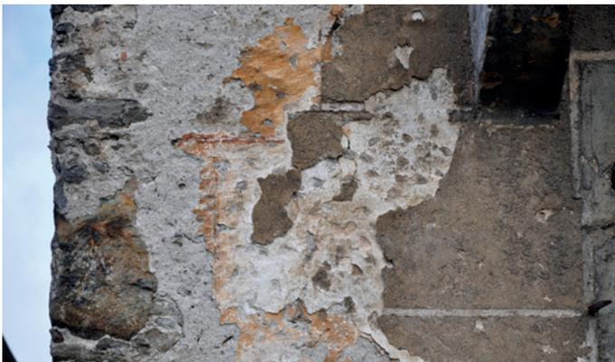
Abb. 43: Detail der Südwestecke mit mehreren Putzschichten und Eckquaderungen (Fürhacker, 2020)
