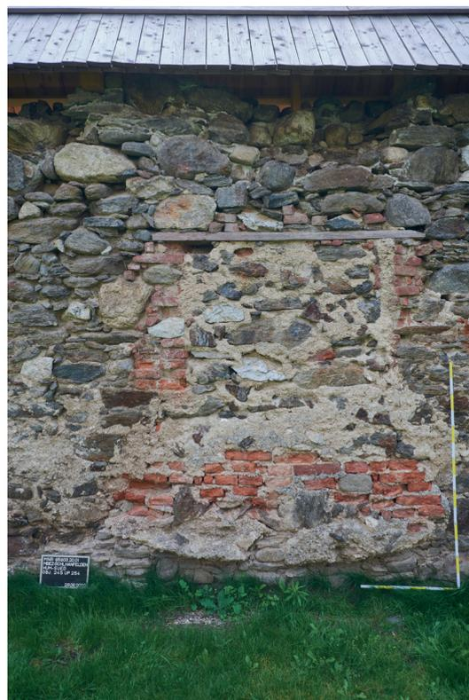
*Abb. 55: Zugemauerte Erschließung bei der Südmauer. (Foto: Bizzarri, 2020. Bearbeitung: Berghof, 2020).*
