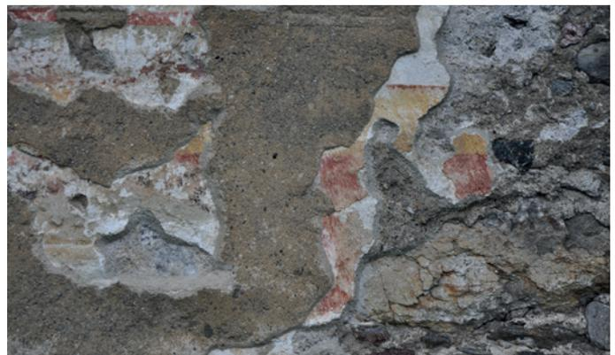
Abb. 44: Detail der konsolidierten Putzschichten an der Südfassade mit farblichen Gestaltungselementen (Fürhacker, 2020)
