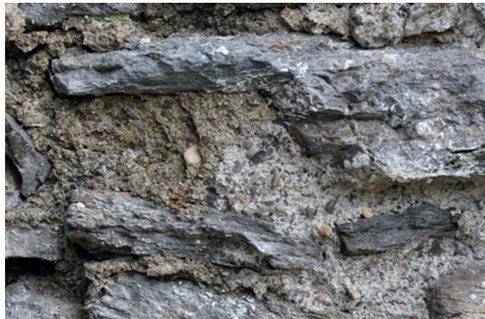
*Abb. 27: Vergleich zwischen historischem (links) und rezentem Mörtel (rechts) (Foto: R. Fürhacker 2015)*
