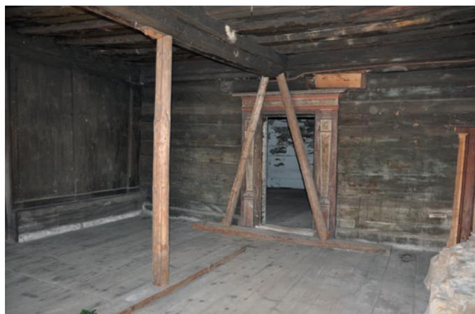
*Abb. 26: Holzstützen in der Blockwerkkammer (Fürhacker, 2020)*
