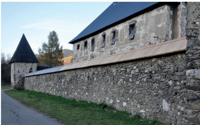
Abb. 30: Westabschnitt der Ringmauer nach der Restaurierung (Fürhacker, 2020)
