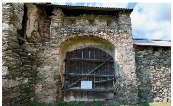
Abb. 46: Nordwestliches Tor. (b) Ansicht vom Süden, hier befindet sich ein aus Mauerziegeln geformter Stichbogen. (Fotos: Bizzarri, 2020. Bearbeitung: Berghof, 2020).
