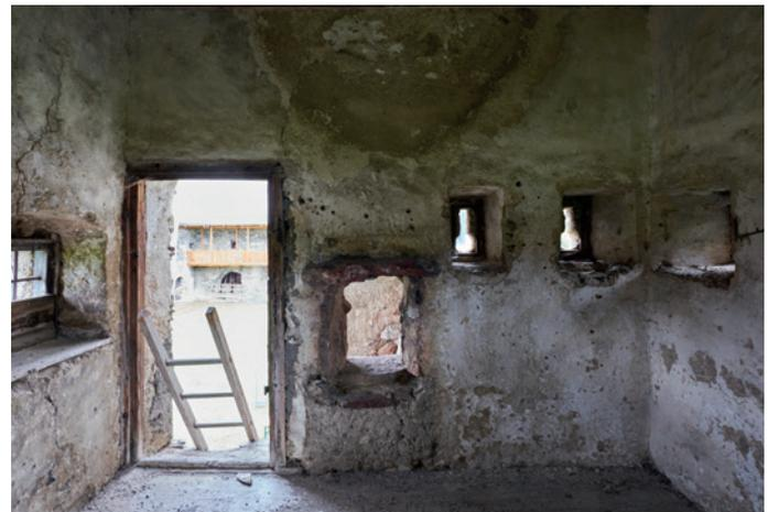
Abb. 50: Ostwand des 1. OGs im Südwestturm. Mittig sind der Durchbruch und der rechteckige Abdruck im Verputz zu sehen, die für eine frühere im Raum angebaute Struktur sprechen. (Foto: Bizzarri, 2020. Bearbeitung: Berghof, 2020).
