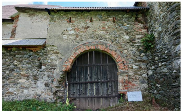
Abb. 45: Nordwestliches Tor. (a) Ansicht vom Norden, mit einem sichtbaren Rundbogen aus Mauerziegeln (Fotos: Bizzarri, 2020. Bearbeitung: Berghof, 2020).
