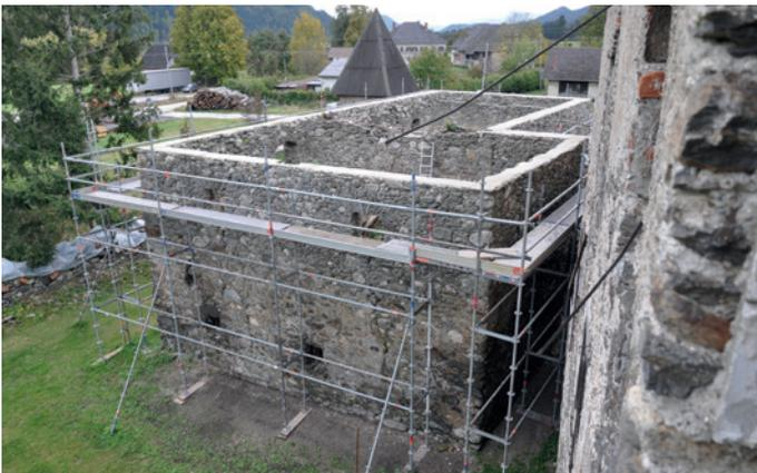
Abb. 34: Eingerüstetes Nebengebäude mit rekonstruierter Mauerbank (Fürhacker, 2016)
