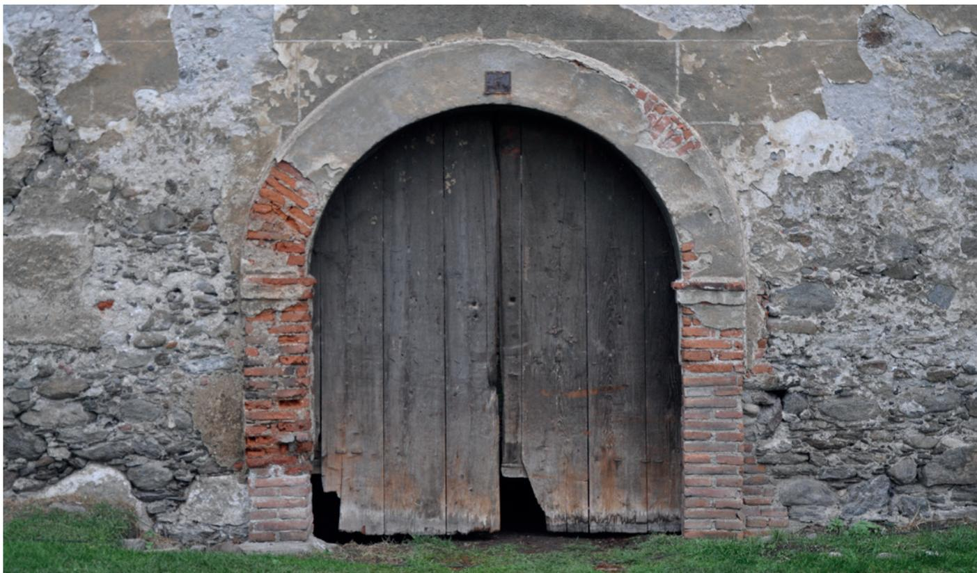
Abb. 39: Tor des Hauptgebäudes nach der Rekonstruktion der Laibung (Fürhacker, 2020)
