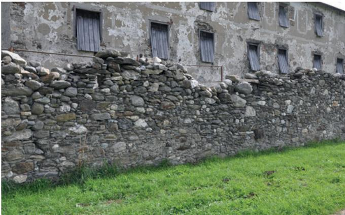
Abb. 29: Westabschnitt der Ringmauer vor der Restaurierung (Fürhacker, 2019)
