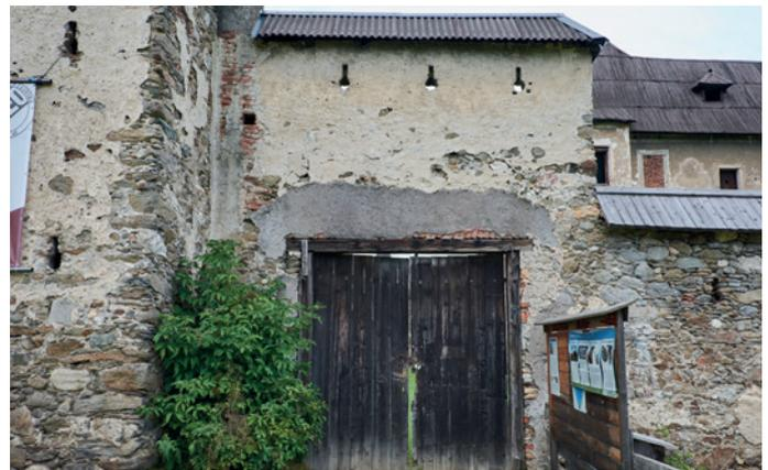
Abb. 47: Südwestliches Tor. (a) Ansicht vom Süden, der waagerechter Sturz wird von einem Schicht dunkelgrauen Verputzes bedeckt (Fotos: Bizzarri, 2020. Bearbeitung: Berghof, 2020).
