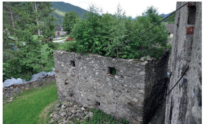
Abb. 32: Nebengebäude ohne Dach mit Baumbewuchs im ersten Obergeschoß (Fürhacker, 2016)
