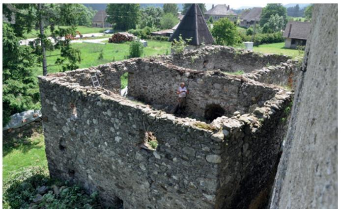
Abb. 33: Nebengebäude nach der Entfernung des Bewuchses und vor der Rekonstruktion der Mauerbank (Fürhacker, 2016)
